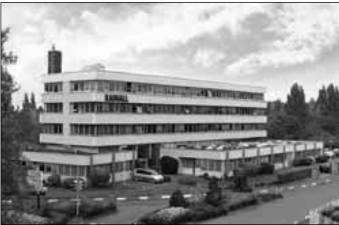
Head Office - Rosny sous Bois
